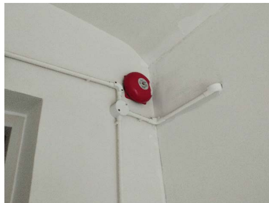
ระบบแจ้งเหตุเพลิงไหม้แบบกริ่ง
